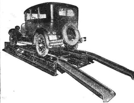
THE RAYBESTOS BRAKE TESTING MACHINE
